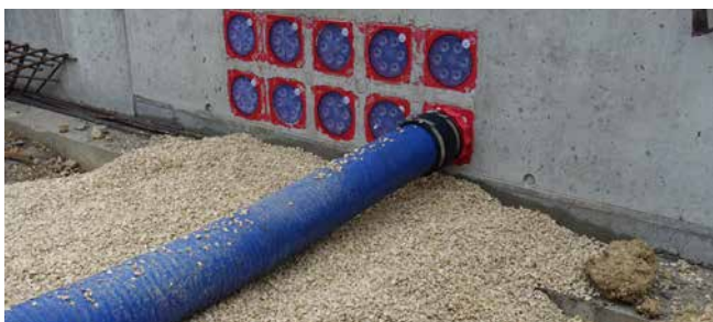
Anschluss des Kabeleinführungssystems KES MA150 D
