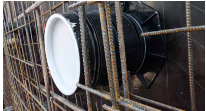
UFR in Schalung
