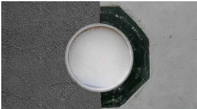
Betoniertes UFR mit PMBC
