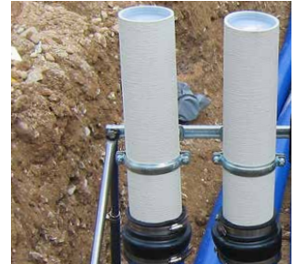
Reihenanzordnung 2x KES MA150 ZVR150/500 an der Aufstellvorrichtung KES FUBO-FIX AV
