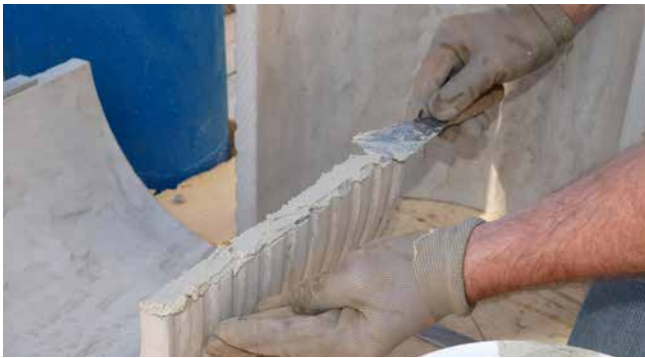
FZRG350/300 mit Spachtelmasse aus Montageset Z-FZR-G
