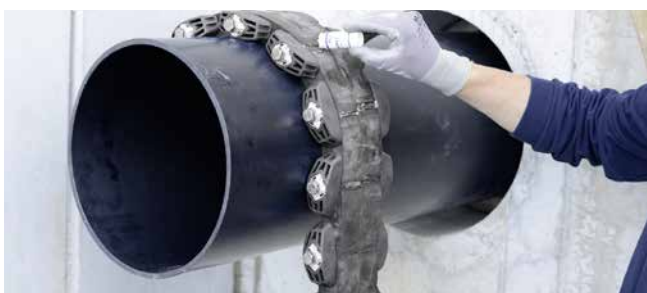
GKD400 – Montagevorbereitung mit Gleitmittel GM
