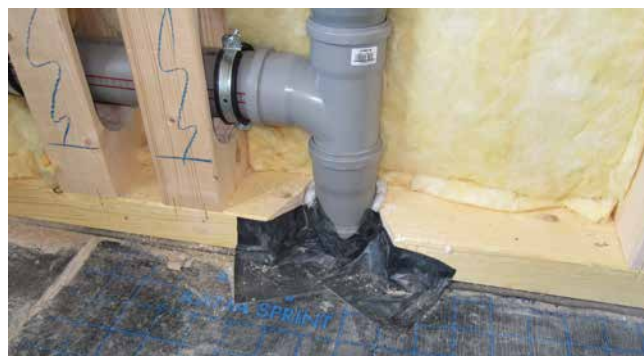
Schwierigkeit: Einbindung der Dampfsperre
