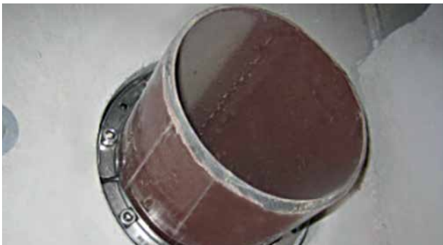
HSD200 1x160 b40 A2/EPDM55 Entwässerung SML Rohr
