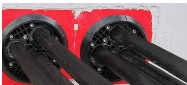
Abdichtung mit Systemdeckel HSI150 DG
