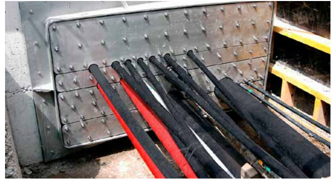
Geteilter Rechteck-Flansch mit Mehrfachbelegung
