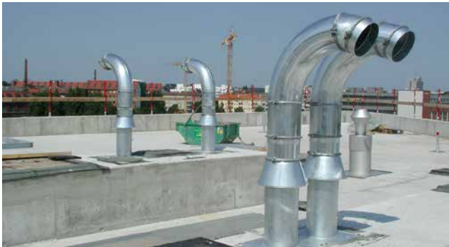
Montierte SHD200 vor Verlegung der Dachabdichtung
