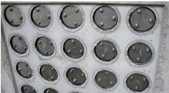
FZR100/240 Abdichtung Rohrtrasse
