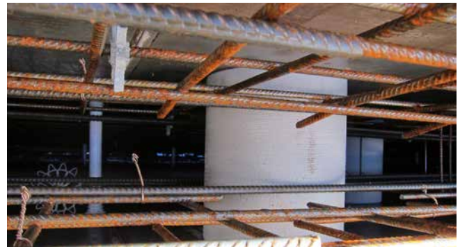
ZVR200/300 in der Schalung fixiert
