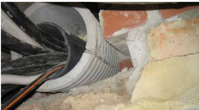
FZR100 / 240 Abdichtung Rohrtrasse
