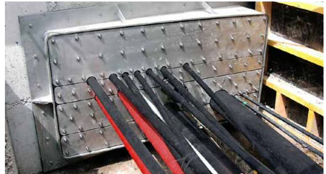
Geteilter Rechteck-Flansch mit Mehrfachbelegung
