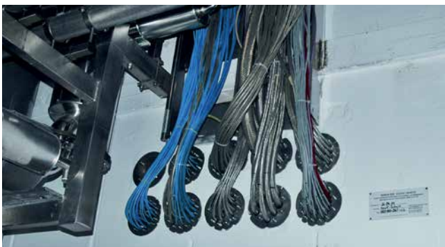
HRD150 G b30 mit Mehrfachbelegung
